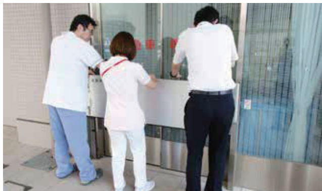
止水板設置の様子
