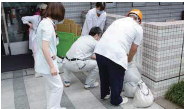
土のう設置の様子
