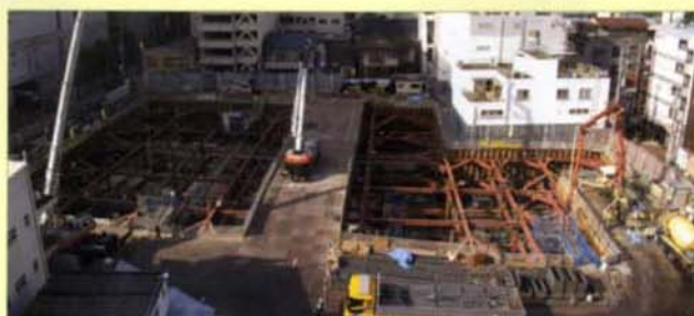
〈4月3日撮影「地下の型枠配筋工事に着手しました」〉
