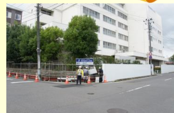
工事用の囲い設置
